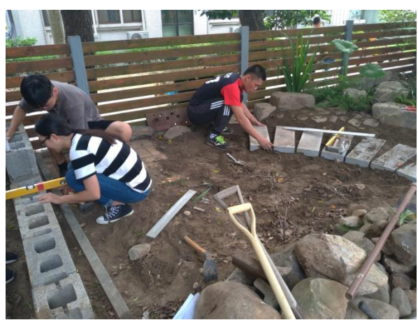
▲學生操作實況-空心磚及石板之鋪設
